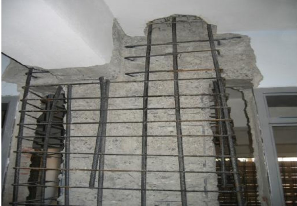
Şekil 5.16. Kolon Mantolama İle Güçlendirme
