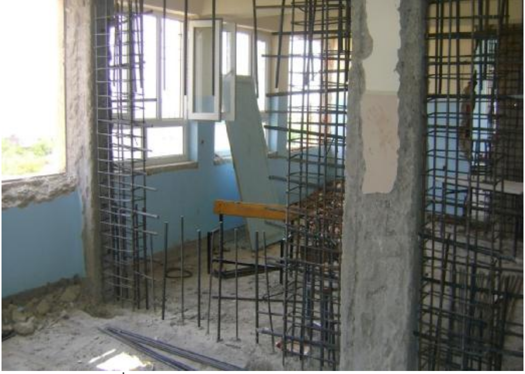
Şekil 5.15. Epoksi İle Donatı Ekimi
