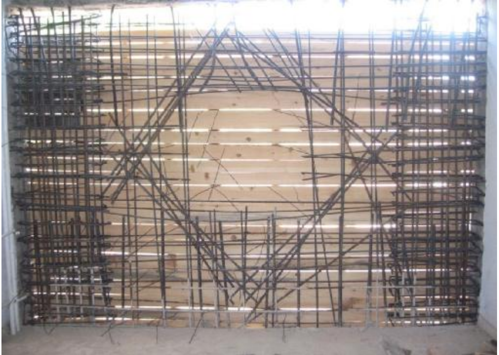
Şekil 5.11. Perde – Kolon Güçlendirme
