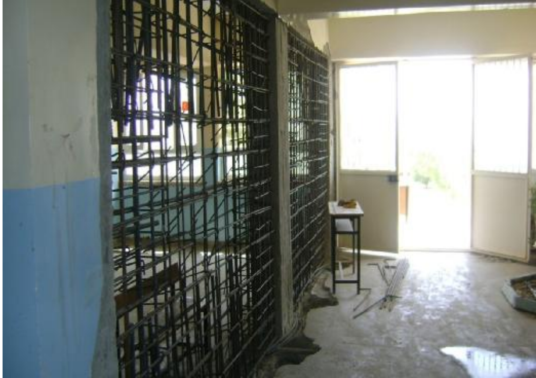
Şekil 5.14. Perde – Kolon Güçlendirme
