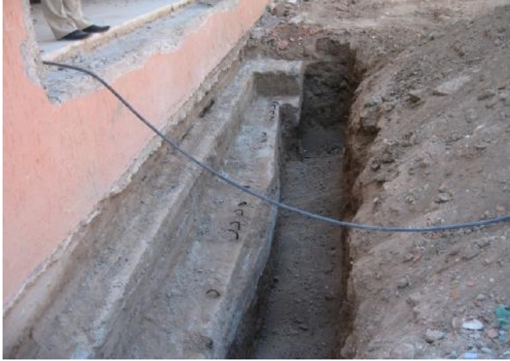
Şekil 5.6. Temel Güçlendirme Kazısı
