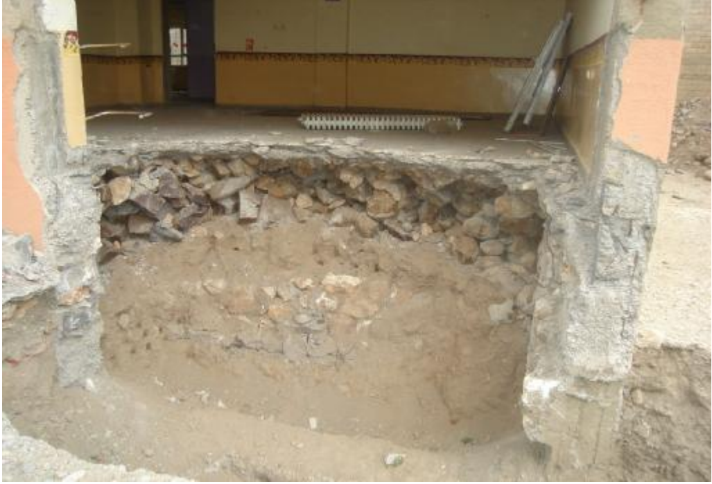
Şekil 5.8. Temel Güçlendirme Kazısı
