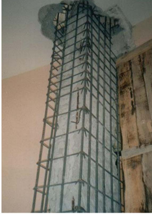
Şekil 3.10. Kesit Büyütme Yöntemi ile Güçlendirilen Bir Kolon Örneği
