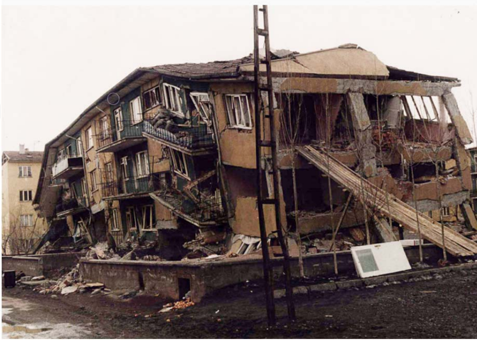
Şekil 1.6. 1992 Erzincan Depremi Sonrası Bir Yapı (AFAD, 2019)
