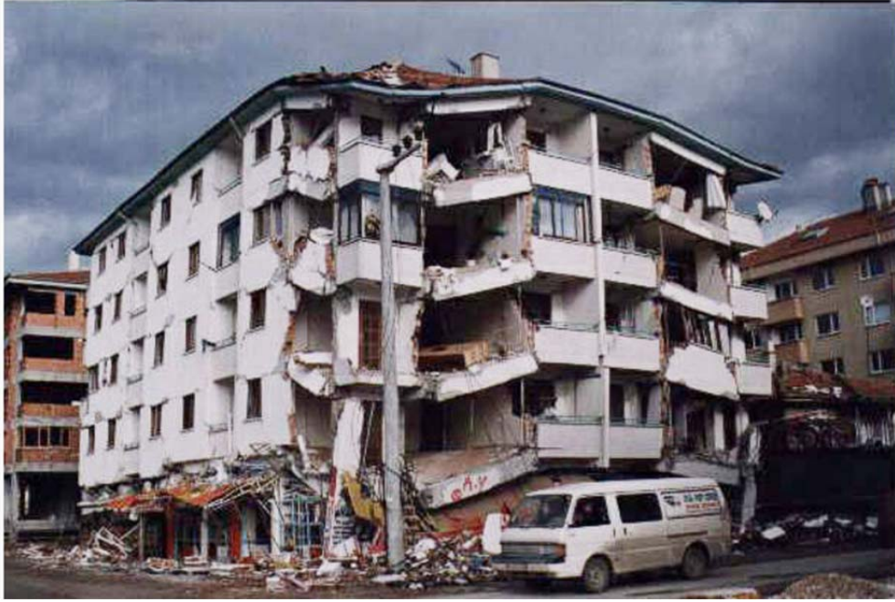
Şekil 1.2. 12 Kasım 1999 Düzce Depremi Sonrası Bir Yapı (AFAD, 2019)
