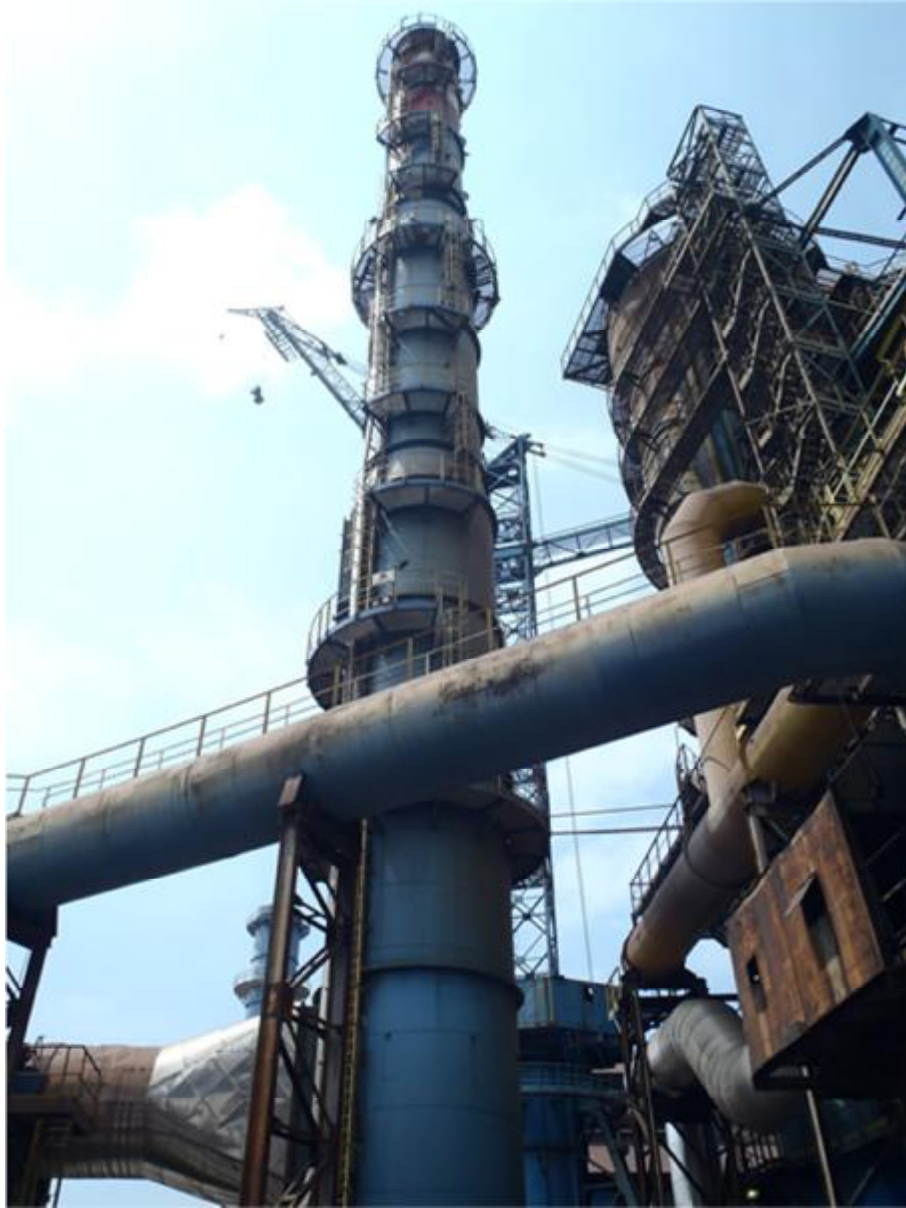
Şekil 1.1. 3.YF bacası genel görünüşü
