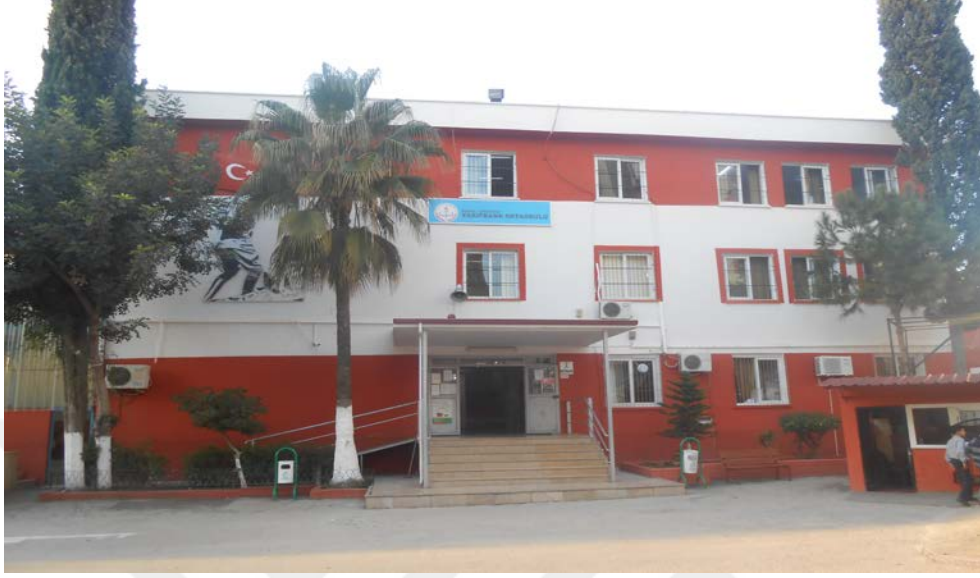
Şekil 4.19 Binanın Güney Cephesi Görünüşü
