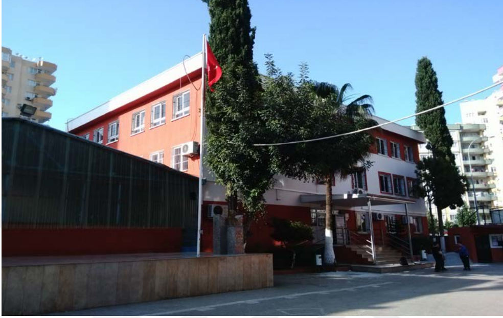
Şekil 4.21 Binanın Güney-Batı Cephesi Görünüşü
