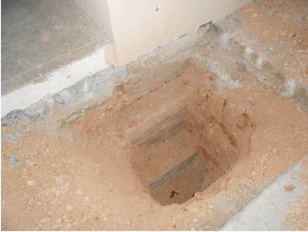
Şekil 4.5 Sabancı İlkokuluna Ait Temel Muayene Çukuru
