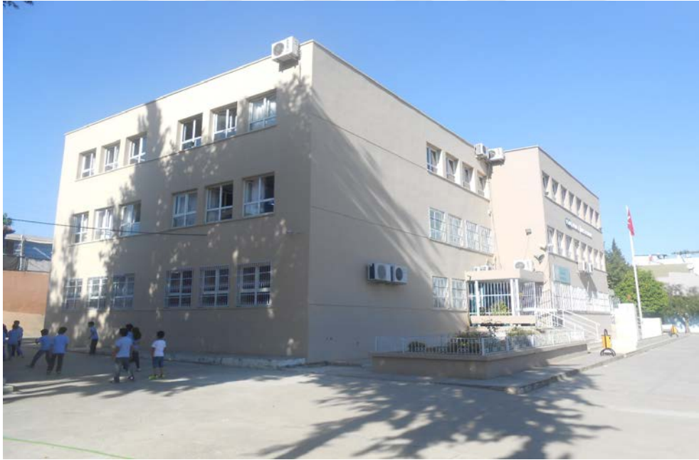
Şekil 4.2 Binanın Güney-Batı Cephesi Görünüşü
