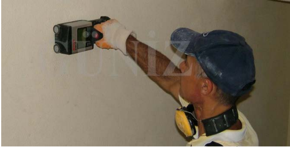
Şekil 4.26 Kolon Yüzünde Tahribatsız Donatı Taraması Yapılması İşlemi
