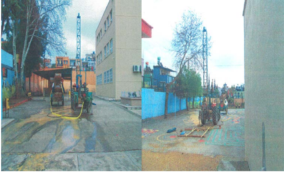
Şekil 4.10-4.11 Sondaj Kuyusu Açılması Çalışmaları
