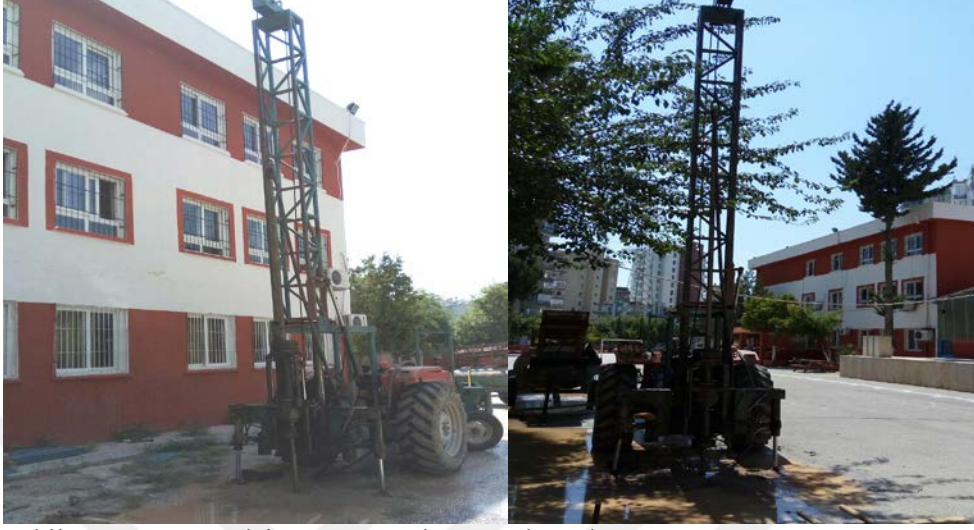
Şekil 4.27-4.28 Sondaj Kuyusu Açılması Çalışmaları
