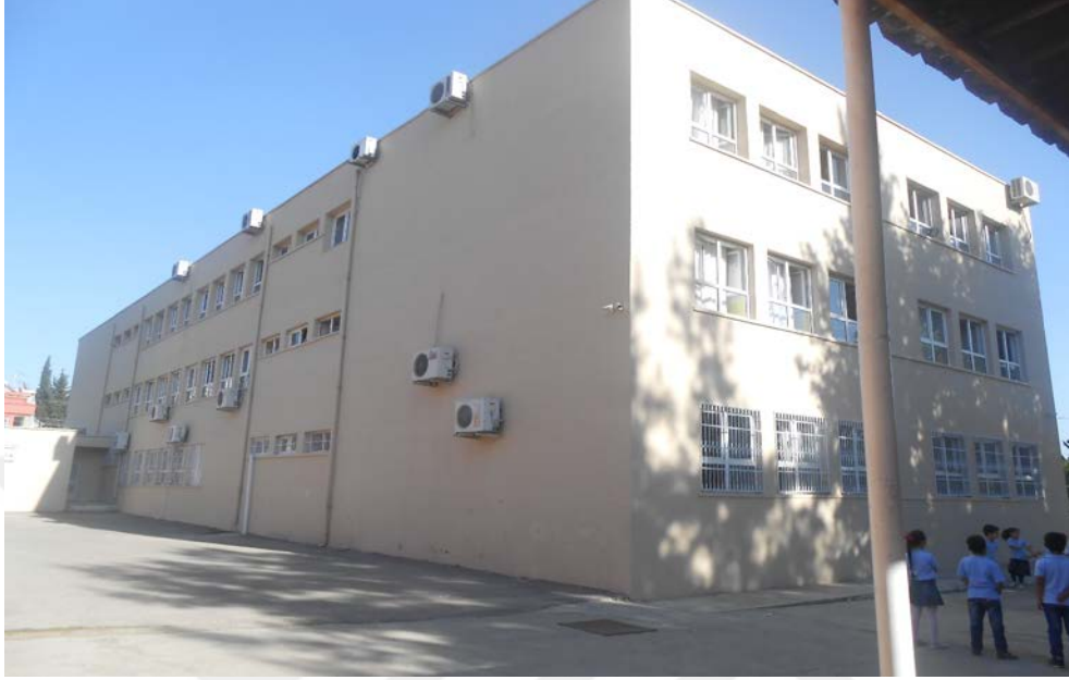
Şekil 4.3 Binanın Kuzey-Batı Cephesi Görünüşü
