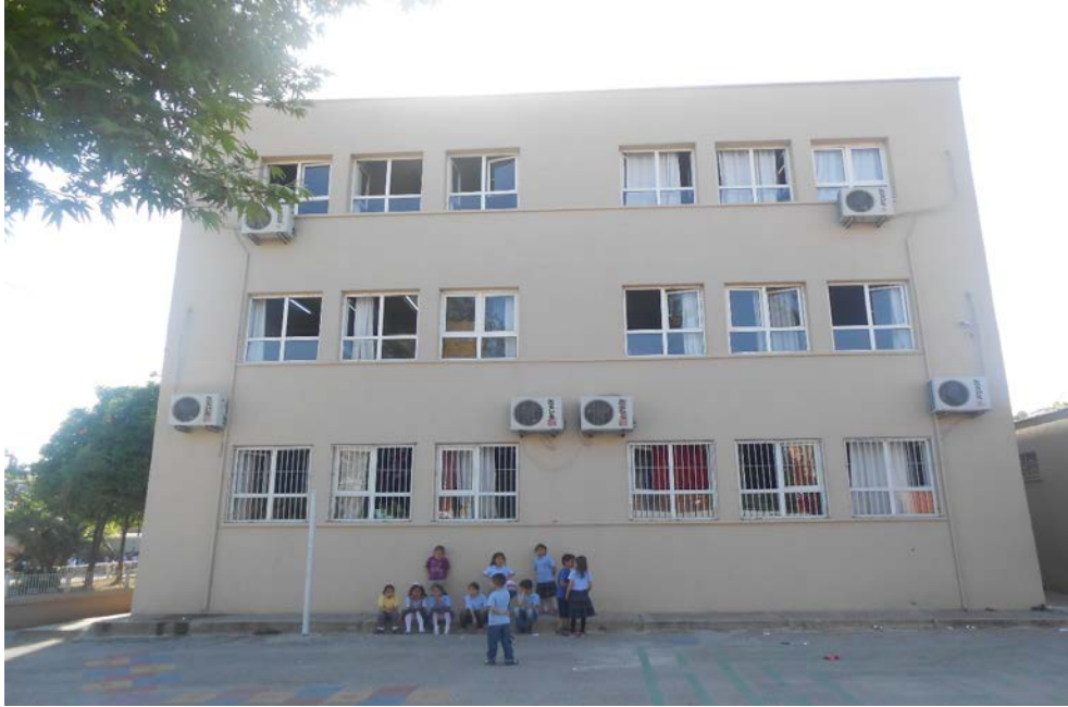
Şekil 4.4 Binanın Doğu Cephesi Görünüşü
