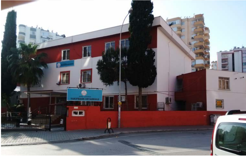
Şekil 4.20 Binanın Güney-Doğu Cephesi Görünüşü
