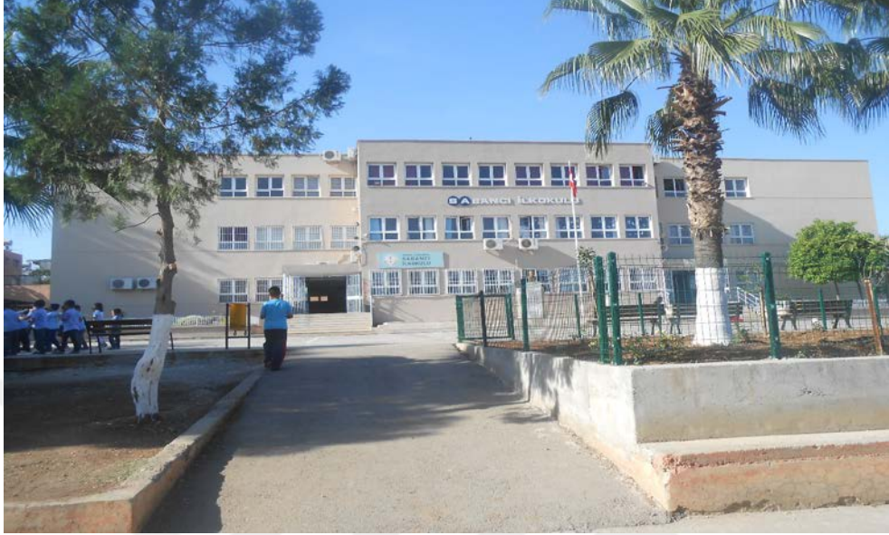
Şekil 4.1 Binanın Güney Cephesi Görünüşü
