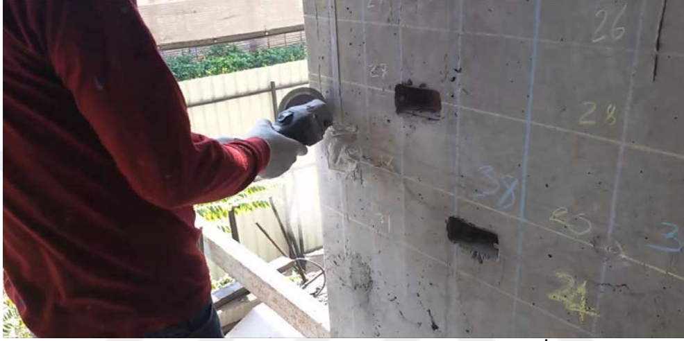
Şekil 4.9 Kolon Yüzünde Tahribatsız Donatı Taraması Yapılması İşlemi
