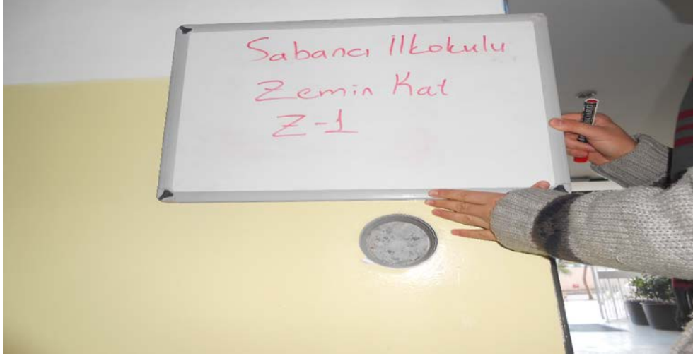
Şekil 4.6 Taşıyıcı Elemandan Beton Numune Alınması
